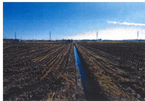
◎排水路底が高いため乾田化が図れない
